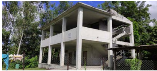
N. Safe Shelter
